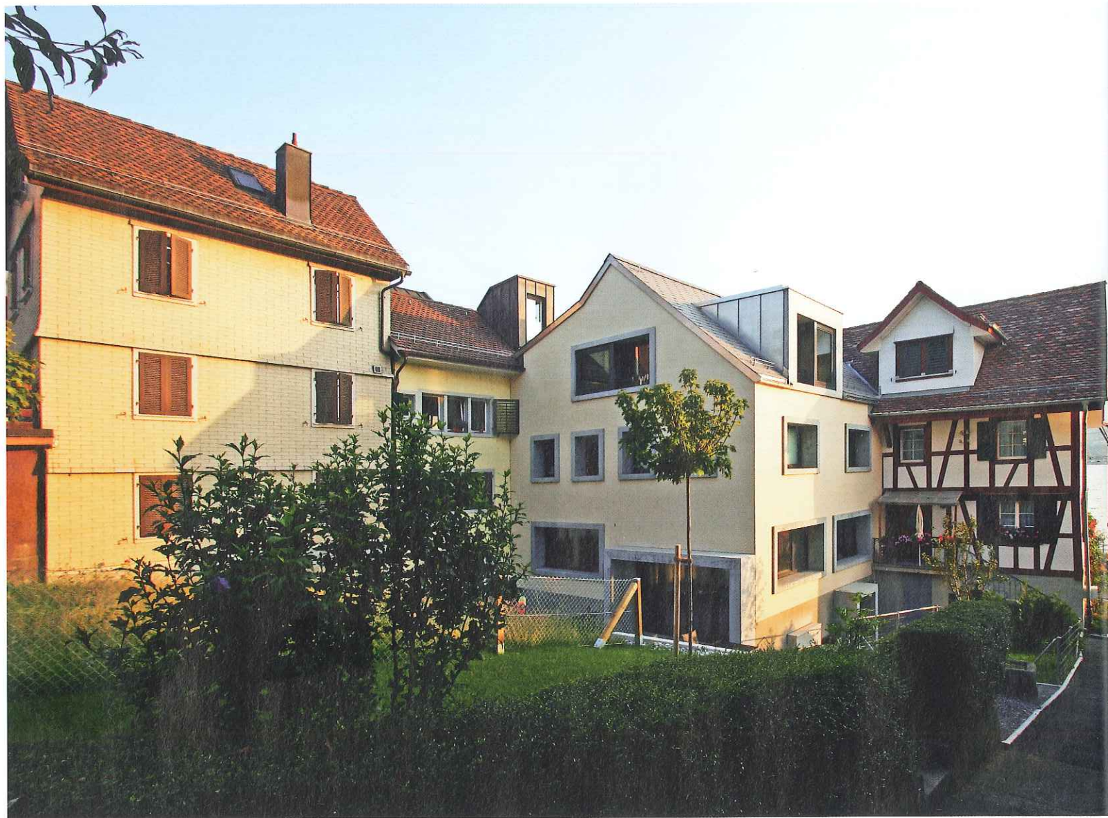
2004 brannte eine Gruppe von historischen Häusern in Horgen aus. Square One Architekten haben eines der vier Bauten durch ein neues Wohn- und Atelierhaus ersetzt.
